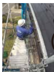
(株)日本住宅保証検査機構による 厳しい完了検査の様子
