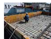
JIO配筋検査
