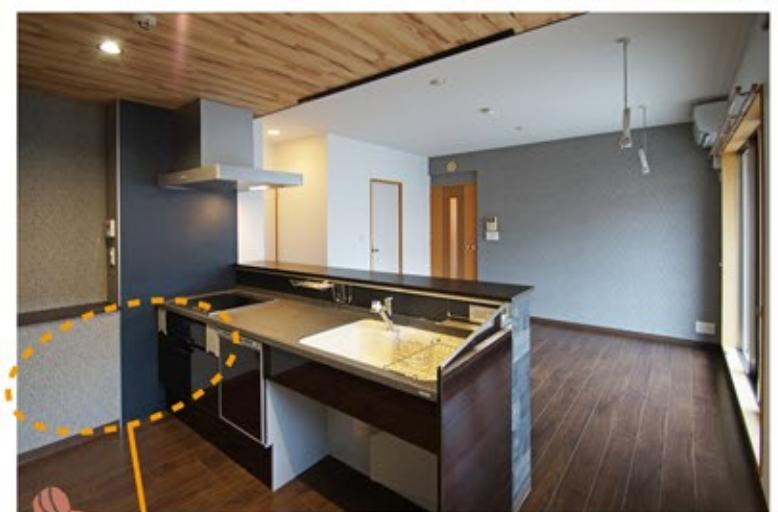
腰壁を造作し、内部に排水管を通してしています。
